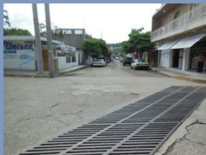
Ilustración 16. Infraestructura Hidráulica Manzanillo.
